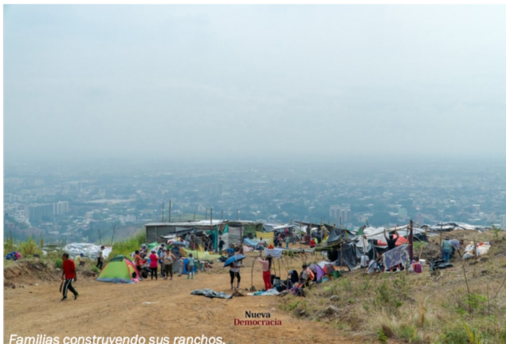
Familias construyendo sus ranchos.
